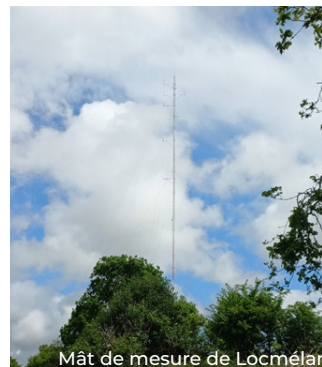
Mât de mesure de Locmélard
